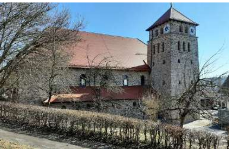
Bild oben: Segnung des neuen Turmkreuzes durch Pater Joseph; Bilder links: Zweimal Pfarrkirche Waffenbrunn: unten eine Aufnahme vom August 2013, oben eine Aufnahme nach der Außenrenovierung im März 2022 – der auffälligste Unterschied ist die neue Dacheindeckung (Bilder: Lydia Preischl)
